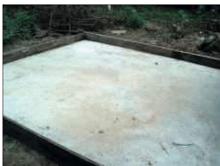
A betontalapzat előkészítése és kiöntése.
