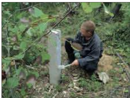
A vasbeton kerítés oszlopainak elkészítése és kihelyezése.
