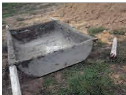
A betontalapzat előkészítése és kiöntése.
